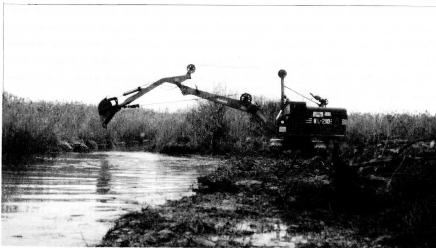
Figur 4. Grävskopa lägger upp lera ur Hidingstabäcken. Foto Jan Sondell
