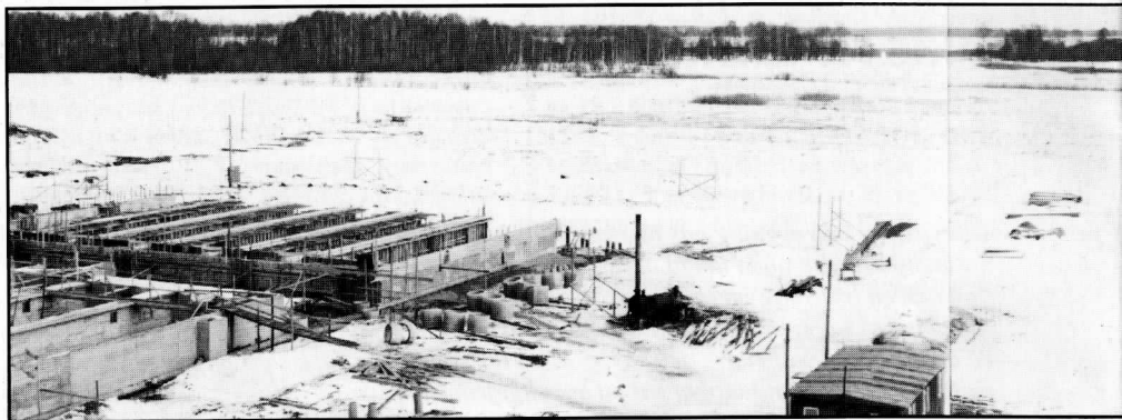
Figur 1 Utsikt över Oset från röt-tornet vid reningsverket under uppförande, februari 1955.
